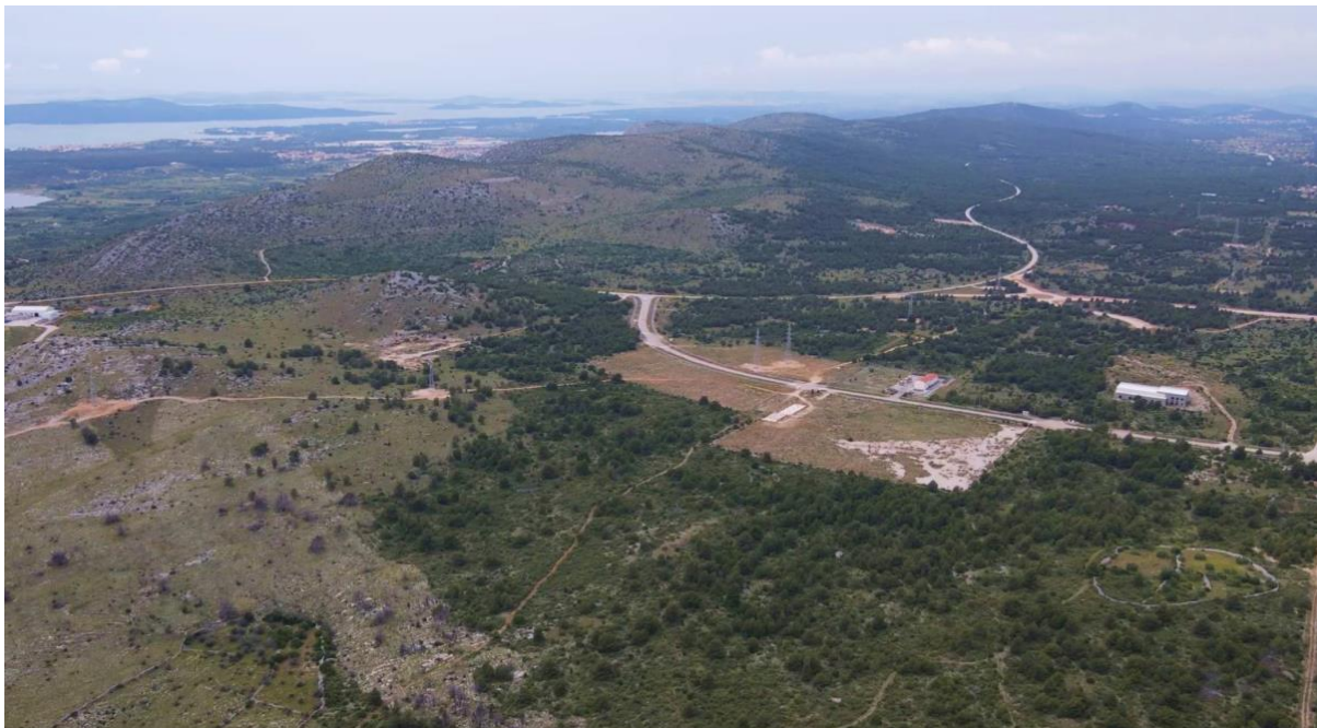
pogled na predmetnu lokaciju iz zraka
